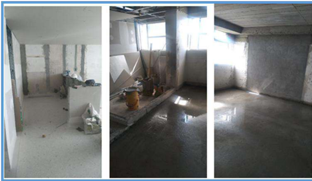
Imagen N.8 Fuente Registro Fotográfico avance de obra Resonador
